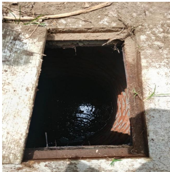
Fuente visita fiscal 27/04/26 Imagen N°12. Disposición final pozo de absorción. Corregimiento de Arabia, Finca la lotería
